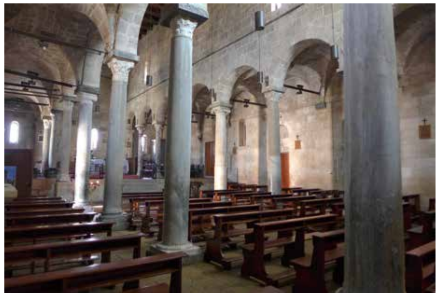
[18] 側廊の天井はクロス・ヴォールト。高窓からの採光が壁を照らす
