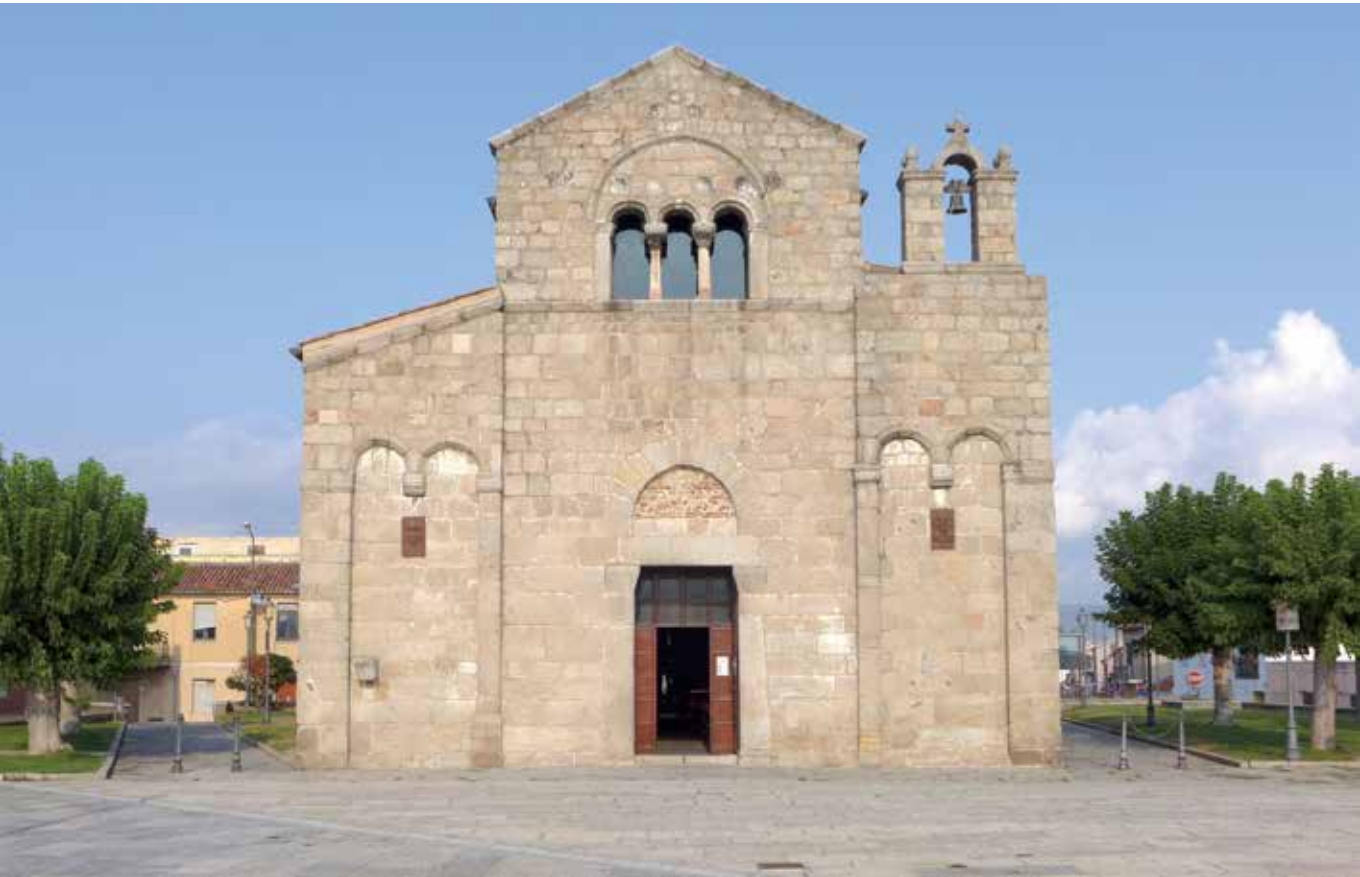
[20] 正面。右の側廊上部に鐘が載り、左右対称を崩す
