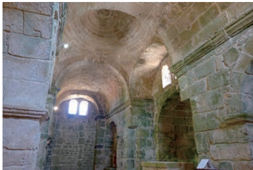
[12] Volta a crociera e pennacchi che partono dai quattro archi
