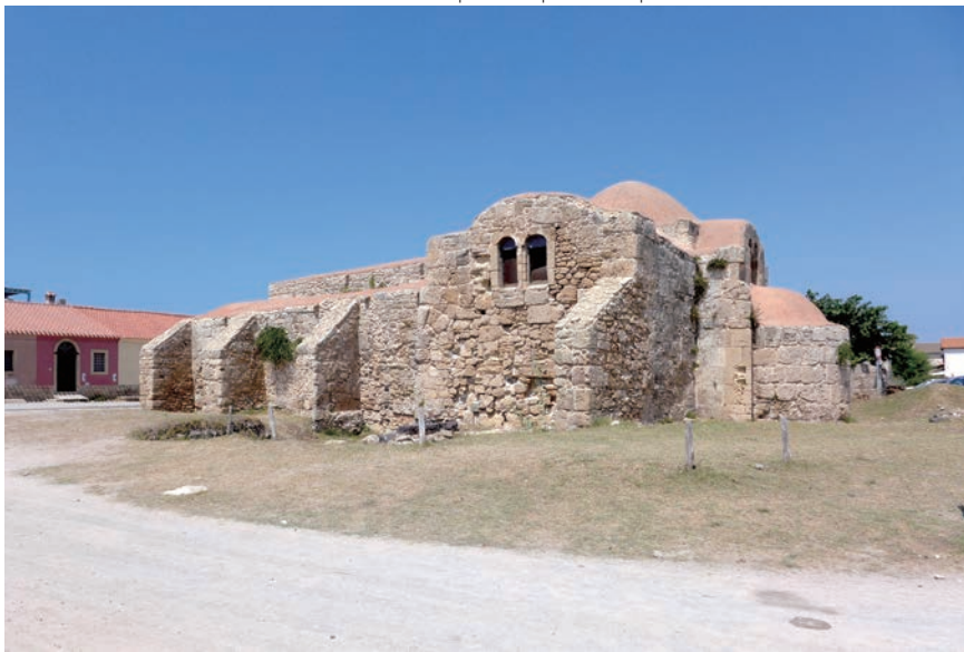
[10] La volta del transetto sporge lateralmente. Ogni elemento è un'aggiunta al transetto
