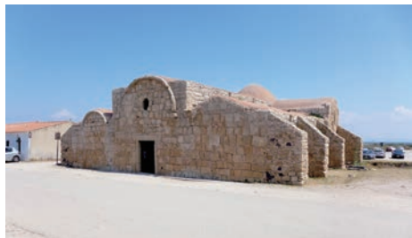
[9] Posizione con vista sul mare. La navata centrale e quelle laterali hanno volte a botte indipendenti
