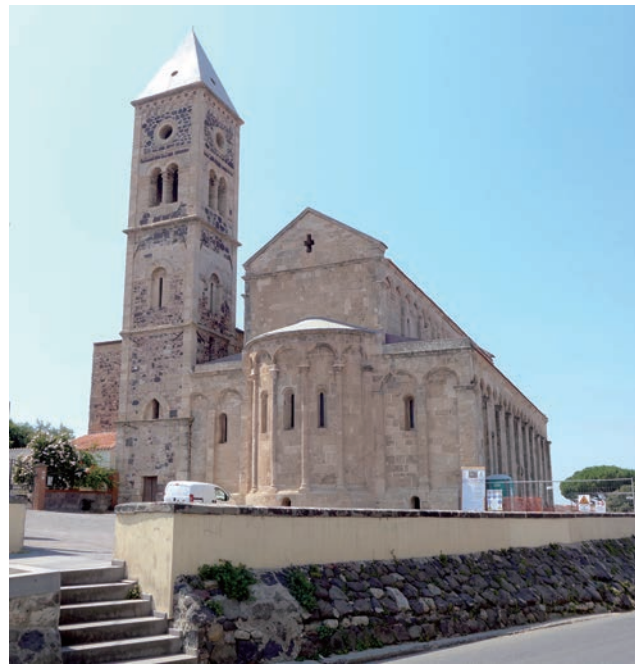
[15] Parete posteriore con abside sporgente. Archetti si rincorrono lungo l'intero perimetro
