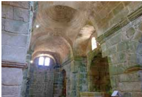
[12] 交差部。4つのアーチ上にかかるペンデンティブドーム
