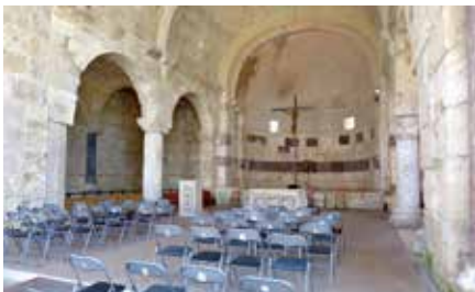
[8] 内陣とアプス。柱は太く長い古代の柱を短く転用したもの
