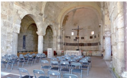
[8] Presbiterio e abside. Le colonne spesse e basse sono un reimpiego di antiche colonne più alte
