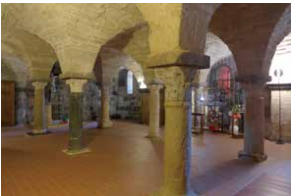
[19] 内陣下部のクリプト(地下聖堂)。柱と柱頭がスボリアを示す。
