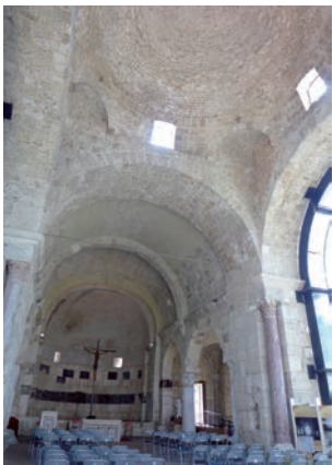
[7] Volta a crociera grande e antica. Il presbiterio in fondo è basso
