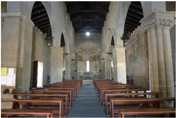
[32] I grandi e sottili archi che separano la navata centrale da quelle laterali mostrano il progresso della tecnica
