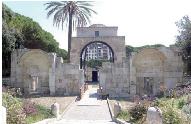
[6] L'attuale facciata corrisponde alla parte frontale dell'ex navata centrale. Lo spazio interno che sopravvive corrisponde alla crociera sormontata dalla cupola
