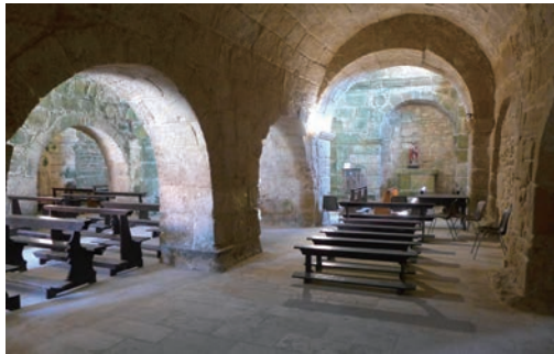
[13] Navata laterale. Lo spessore della parete dell'arco corrisponde a quello della parete
